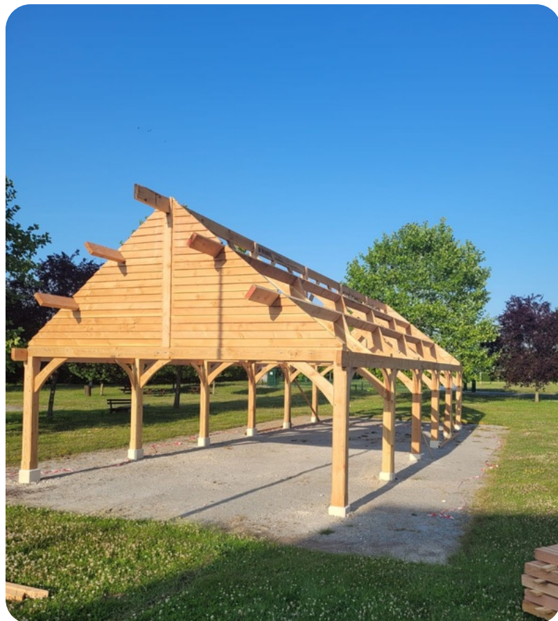
Le préau en construction, juin 2025
