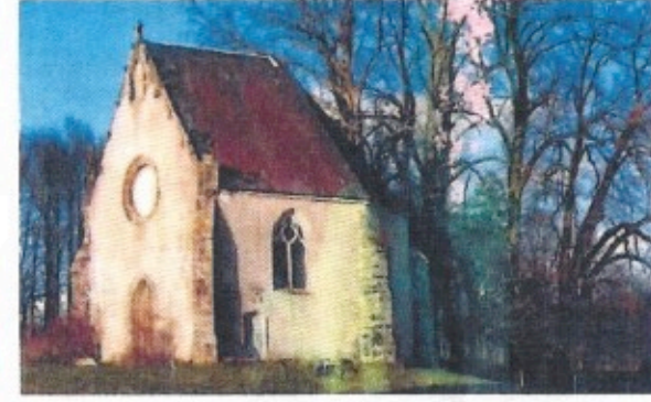
L'ancienne église paroissiale dédiée à Notre-Dame est constituée d'une nef aux murs contrefortés. Le pignon est percé d'une porte gothique surmontée d'un oculus aveugle. Le chevet est formé par trois pans coupés.
